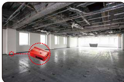
施工現場などでの多点観測
